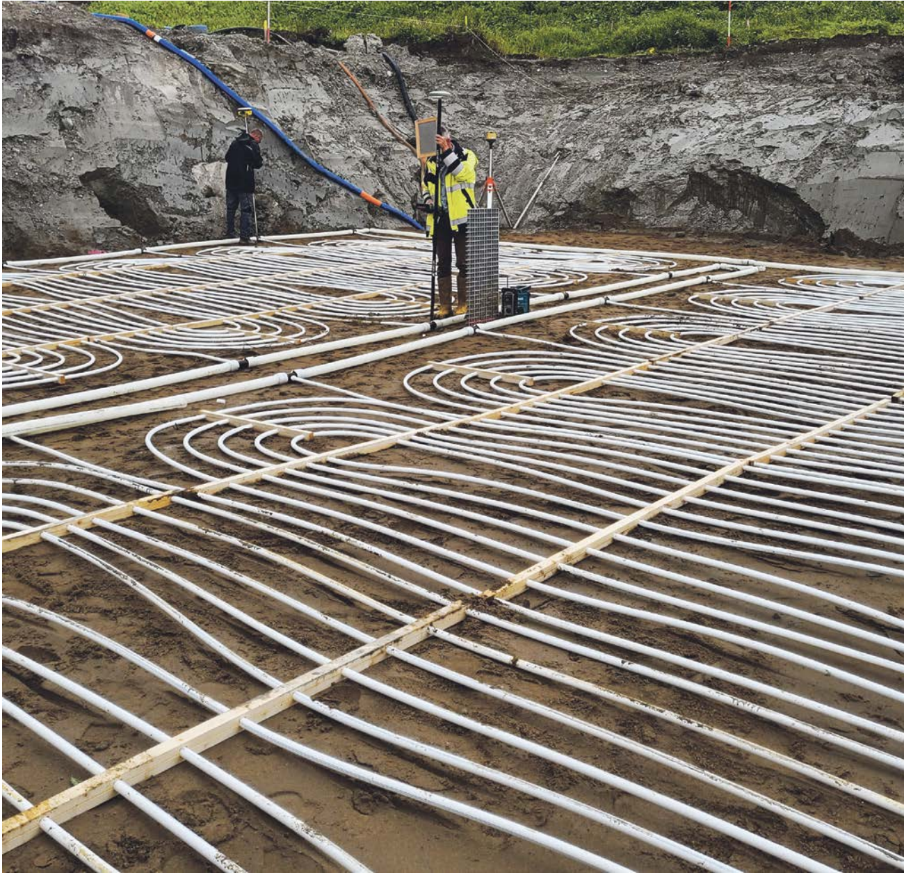
Im Bau Im Norden Schlesiens hat sich in den letzten Monaten viel getan. Mittlerweile speist der Erdwärmespeicher erste Wärme ein.
